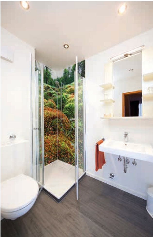
Im Hotel zur Post in Kell am See steht man in der Dusche direkt im Moor. Die fugenlosen bedruckten Platten sind nicht nur ein absoluter Hingucker, sie sind sogar dank der nicht vorhandenen Fugen hygienischer und weniger anfällig für Schimmelbildung.
