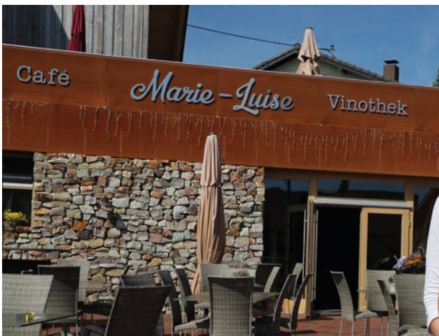
Verwitterter Cortenstahl in Verbindung mit einer Trockenbruchsteinmauer setzt besondere Farbakzente in natürlichen Tönen.
