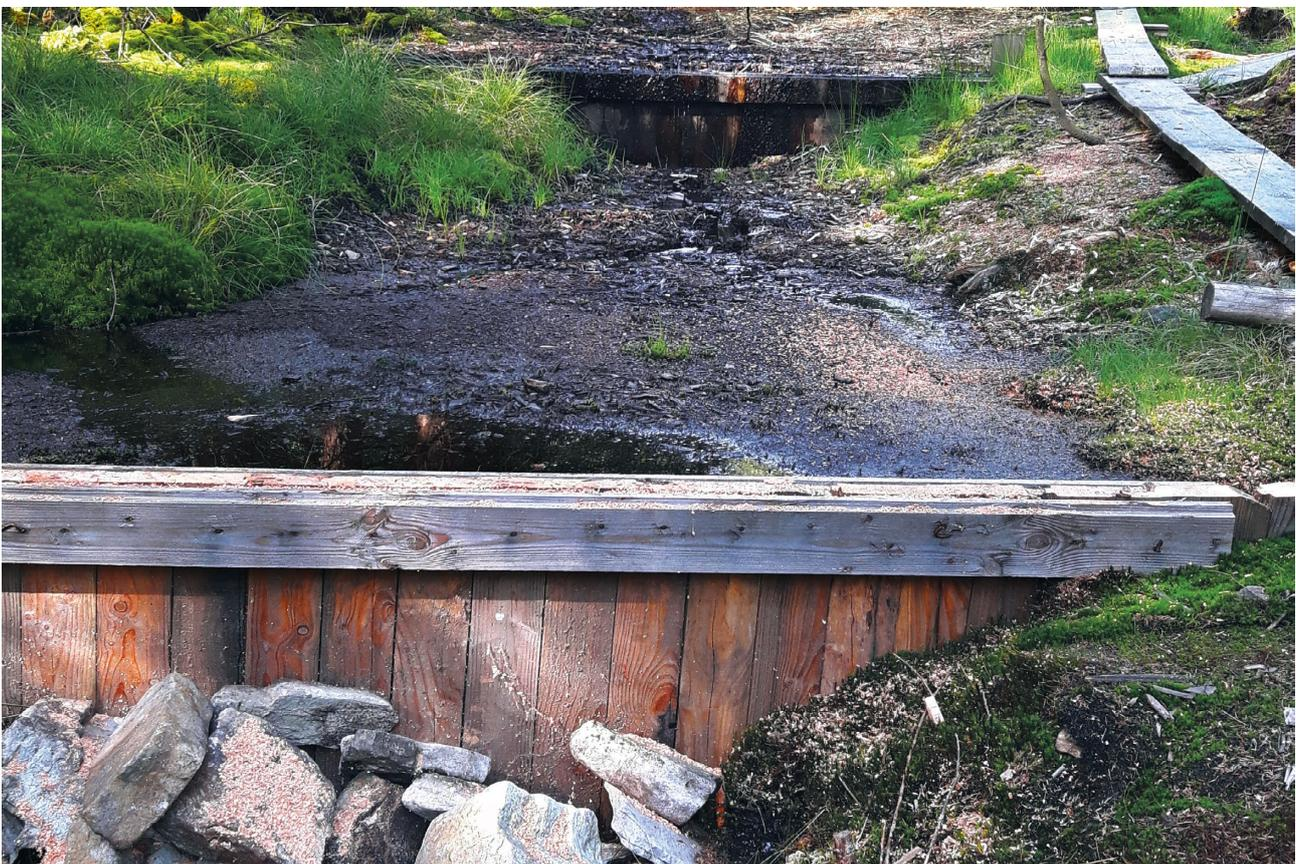
**Abbildung 4:** Verfüllung nach Zuger Methode im Tierchbruch. (Fotos: J. Zemke)
