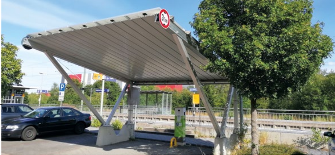
E-Mobil Ladestandort unter einem Solarcarport am Bahnhof in Neubrücke (Foto: Y. Recktenwald)
